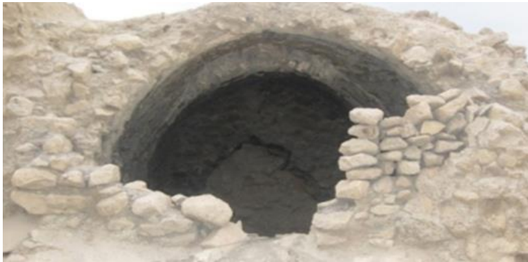
بخشی از ابنیه‌ی باقی مانده در ضلع شمال شرقی
