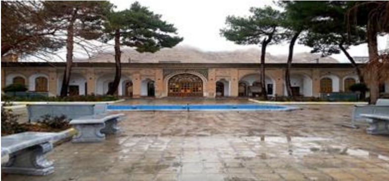
بخشی از نمای بیرونی کاخ والی
